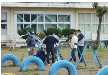
鉄棒の杭打ち
